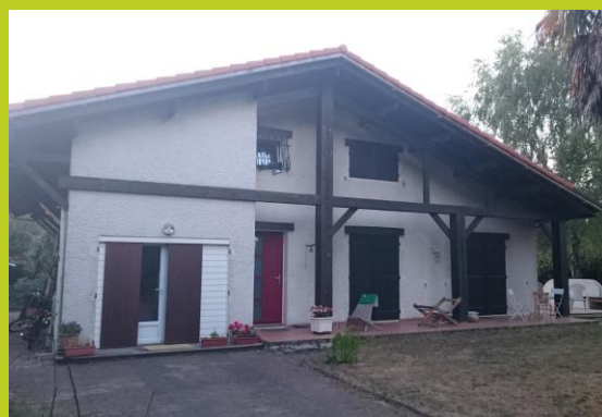
Photo 1: Logement avant rénovation
