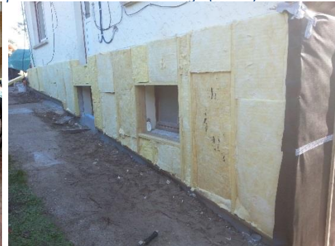
Photo 4 : Isolation thermique des murs par l'extérieur avec traitement du bas de murs.
