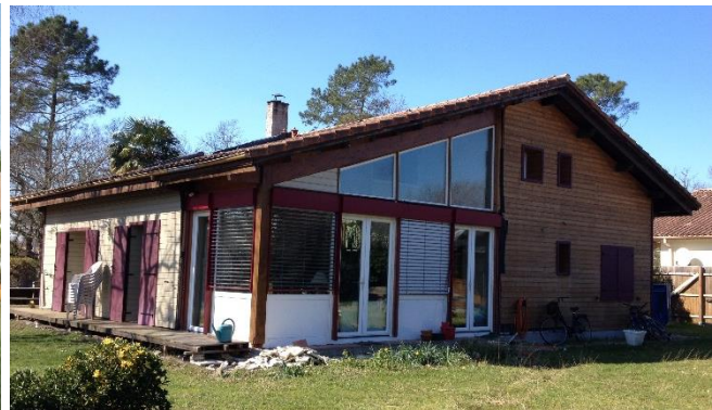
Photos 1 : Maison avant rénovation avec enduit ancien (gauche) et après rénovation avec bardage (droite)
