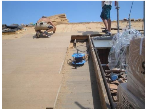
Photo 4 : Isolation en fibre de bois des rampants.
